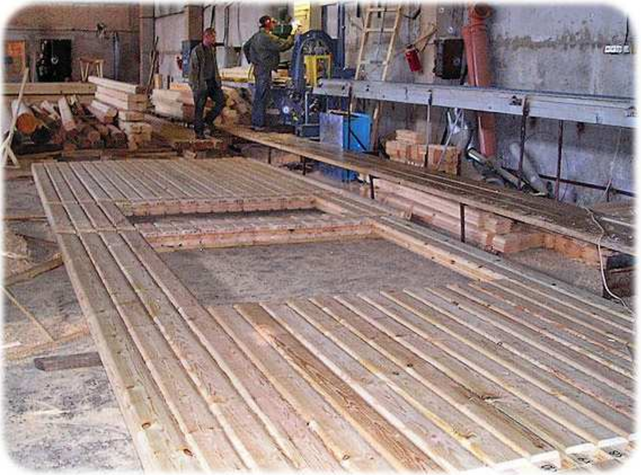
Montage du chalet à la fabrique en Biélorussie pour contrôle avant expédition
